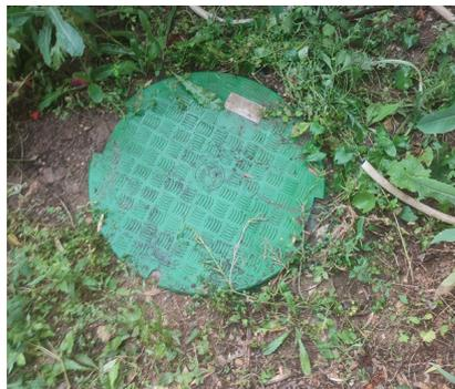
Le regard de la pompe de relèvement d'évacuation des eaux usées du garage qui permet que les eaux venant de la machine à laver rejoignent bien le circuit normal des eaux usées
